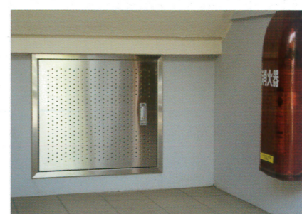
P3 床下点検口
